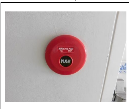
ภาพที่ 2.3-34 อุปกรณ์แจ้งเหตุด้วยมือ
