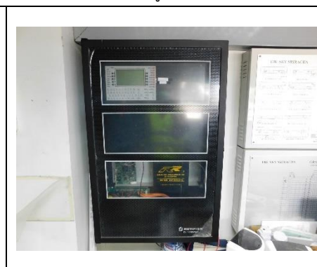
ภาพที่ 2.3-35 ตู้ควบคุมระบบแจ้งเหตุเพลิงไหม้
