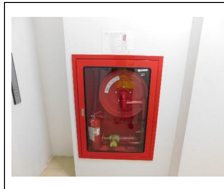
ภาพที่ 2.3-33 ตู้สายฉีดน้ำดับเพลิง
